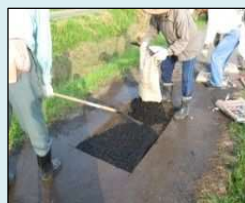
農道の部分補修
