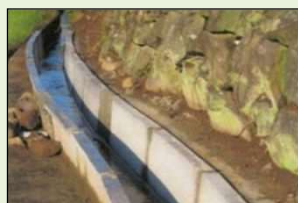
素堀り水路からの更新
