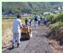
未舗装農道の舗装
