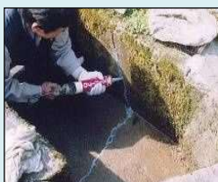
ひび割れの補修
