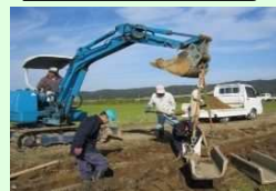
コンクリート水路の更新
