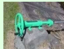
ゲート、バルブの更新
