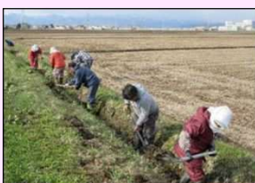
水路の泥上げ
