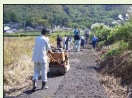
未舗装農道の舗装
