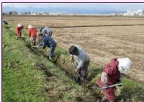
水路の泥上げ
