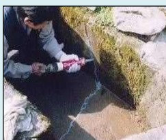
ひび割れの補修
