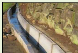
素堀り水路からの更新
