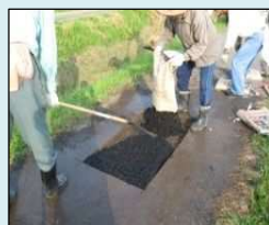
農道の部分補修
