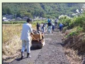
未舗装農道の舗装
