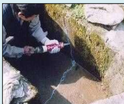
ひび割れの補修
