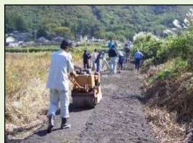
未舗装農道の舗装
