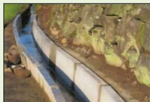
素堀り水路からの更新
