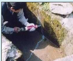
ひび割れの補修
