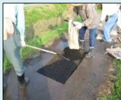
農道の部分補修
