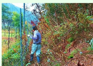
鳥獣防護柵の点検・補修
