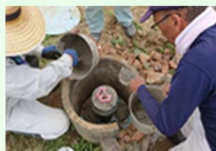
バルブの補修作業
