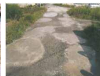
農道の窪みの補修
