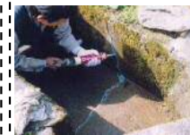
水路のひび割れ補修
