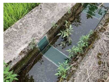
施工10年後の状態（シートの剥がれもなく、水もしっかり止まっている）
