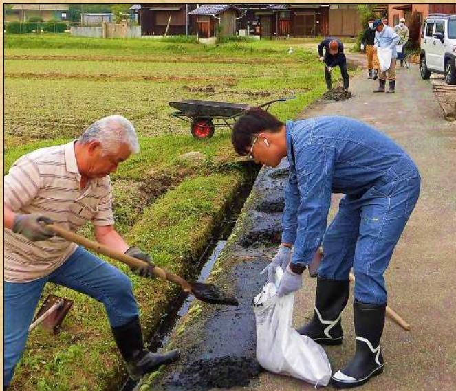
①水路の泥上げ
