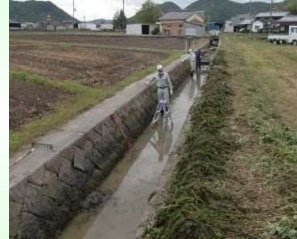
水路の泥上げ
