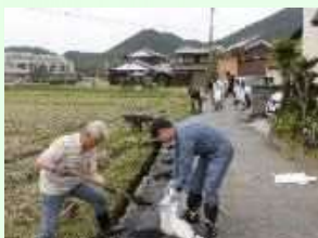
水路の泥上げ
