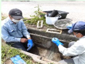
水路の軽微な補修
