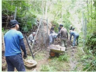
鳥獣防護柵の点検・補修
