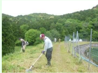
ため池堰堤草刈り
