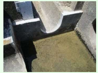
会所桝の補修
