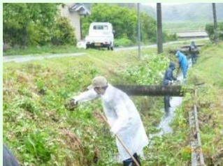
水路の草刈り・泥上げ
