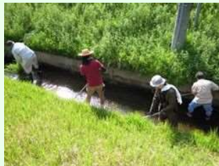
水路の泥上げ
