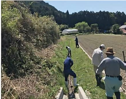
点検・機能診断
