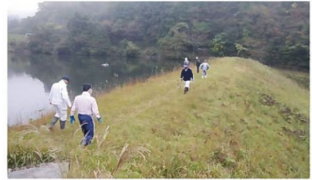
ため池の点検・機能診断
