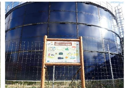
箸荷バイオガス発電所
