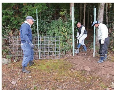
防護柵の補修・設置
