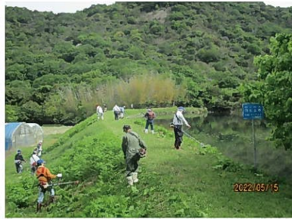
ため池法面の草刈り
