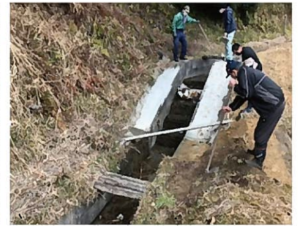
一部直営施工による水路の工事
