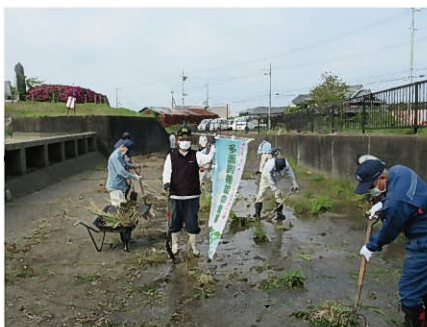
水路の泥上げ
