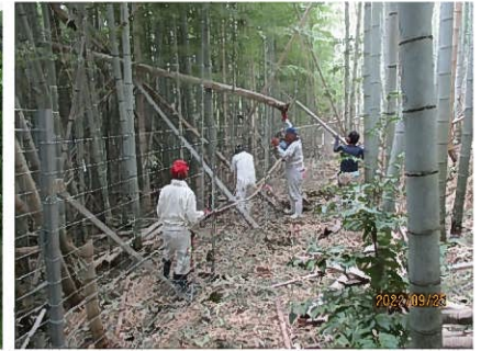
鳥獣防護柵の補修
