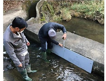
補修工事検収
