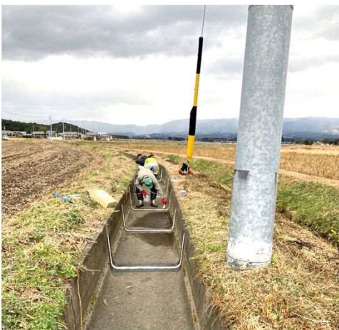
活動組織での直営施工
