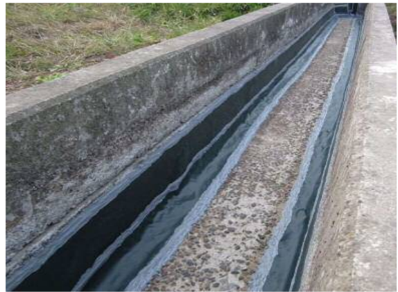
現場打ち水路
