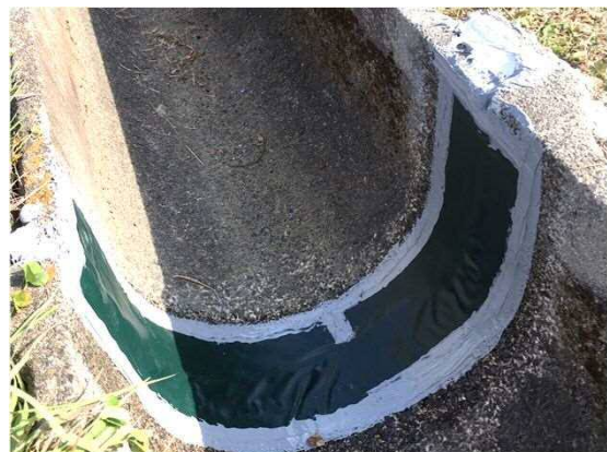
底面が丸い水路
