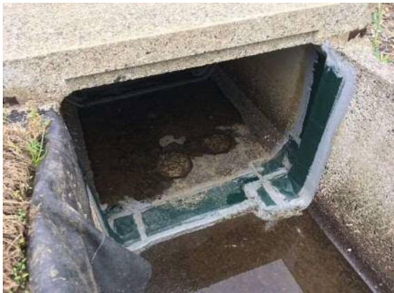
マス、ボックスとの繋ぎ目
