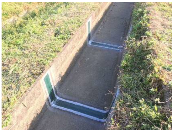
幅の広い水路
