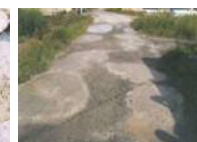
農道の窪みの補修
