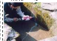
水路のひび割れ補修
