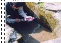
水路のひび割れ補修
