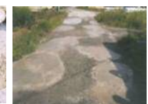
農道の窪みの補修
