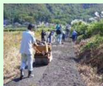
未舗装農道の舗装
