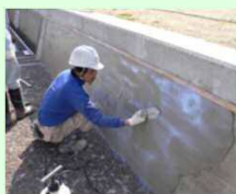
水路壁の表面被覆
