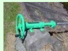
ゲート、バルブの更新
