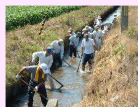
水路の泥上げ
