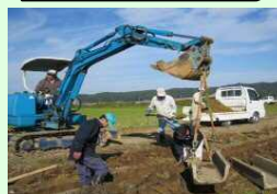
コンクリート水路の更新
