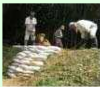
漏水箇所の補修
