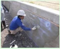
水路壁の表面被覆
