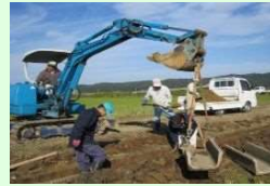
コンクリート水路の更新
