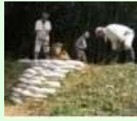
漏水箇所の補修
