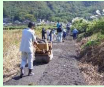
未舗装農道の舗装
