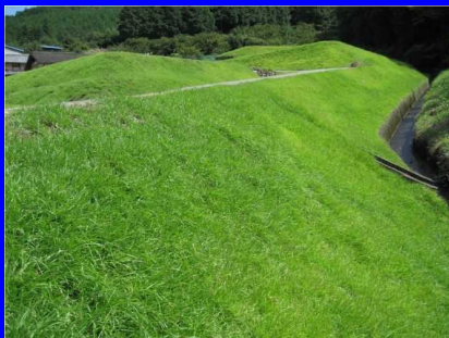
完成直後の様子
