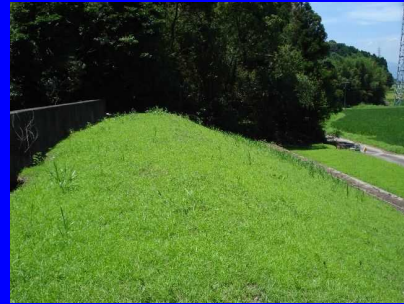
施工後の様子
