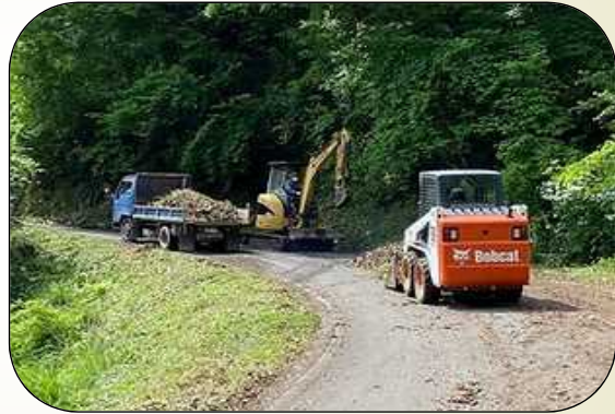
農道側溝の泥上げ
