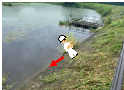
(ため池堤体の急傾斜)
