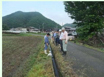
水路の点検・機能診断
