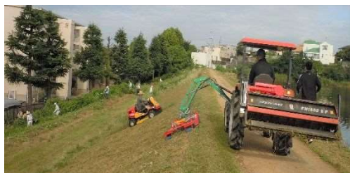
地区内ため池法面の草刈作業
