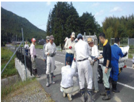
施設の点検・機能診断
