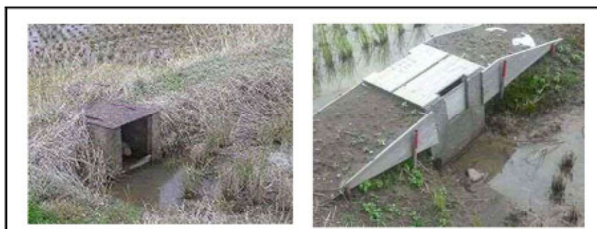
事故前の溜め升
