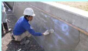
老朽化した水路壁のコーティング
