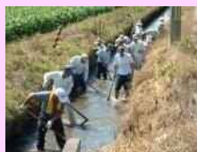
水路の泥上げ
