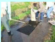
農道の部分補修
