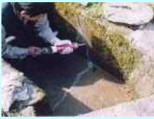
水路のひび割れ補修
