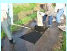
農道の部分補修
