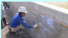
老朽化した水路壁のコーティング
