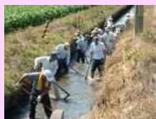
水路の泥上げ
