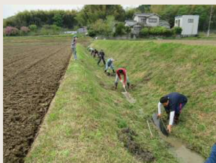
水路の泥上げ
