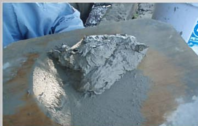
② 混練り状況
