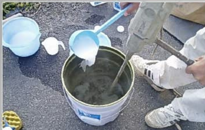
① 混練り状況
