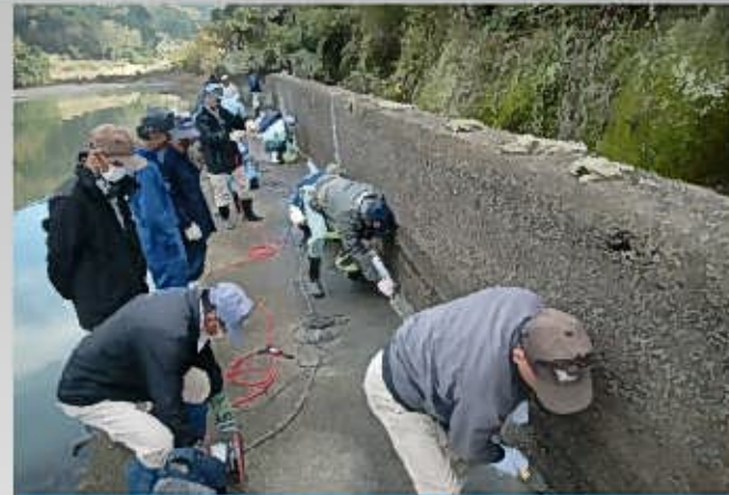
③ ハンチ設置状況
