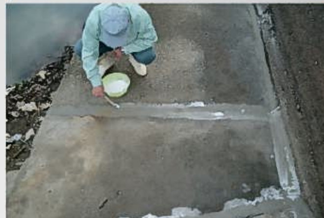
④ ひび割れ補修状況
