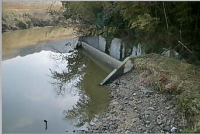
① 洪水吐流出部状況
