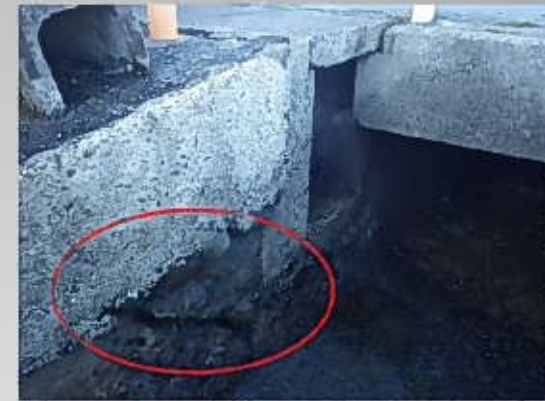
② 湧水部の補修
