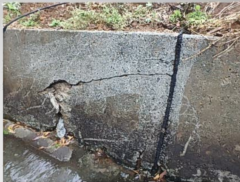
水路側壁部のはく離・欠損
