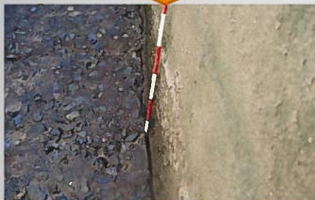
② 隅部の状況
