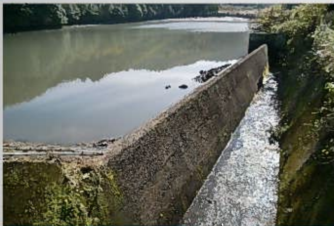
② 洪水吐流出部状況
