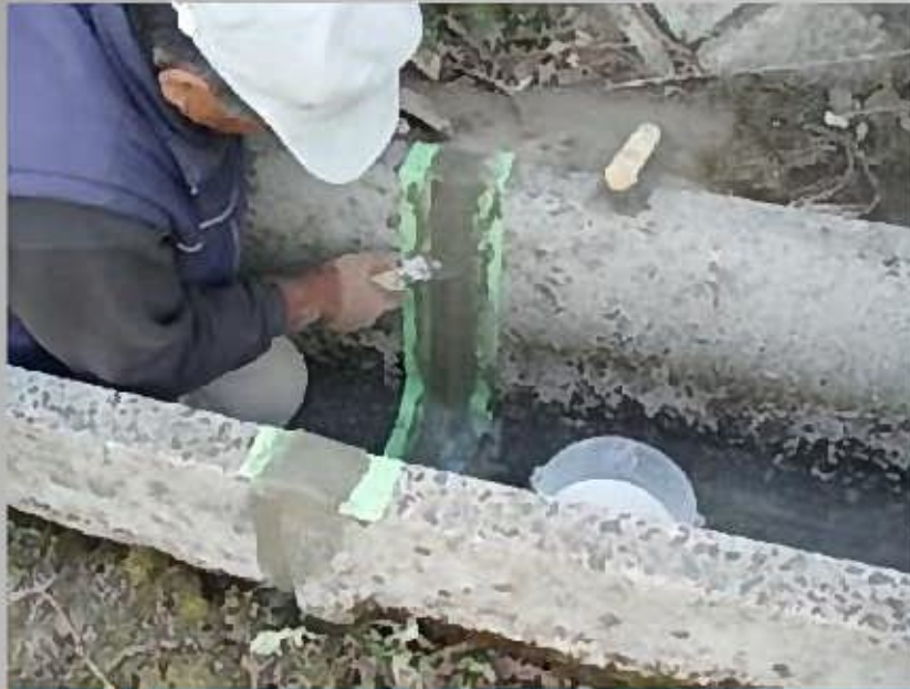
①コテ等による補修状況
