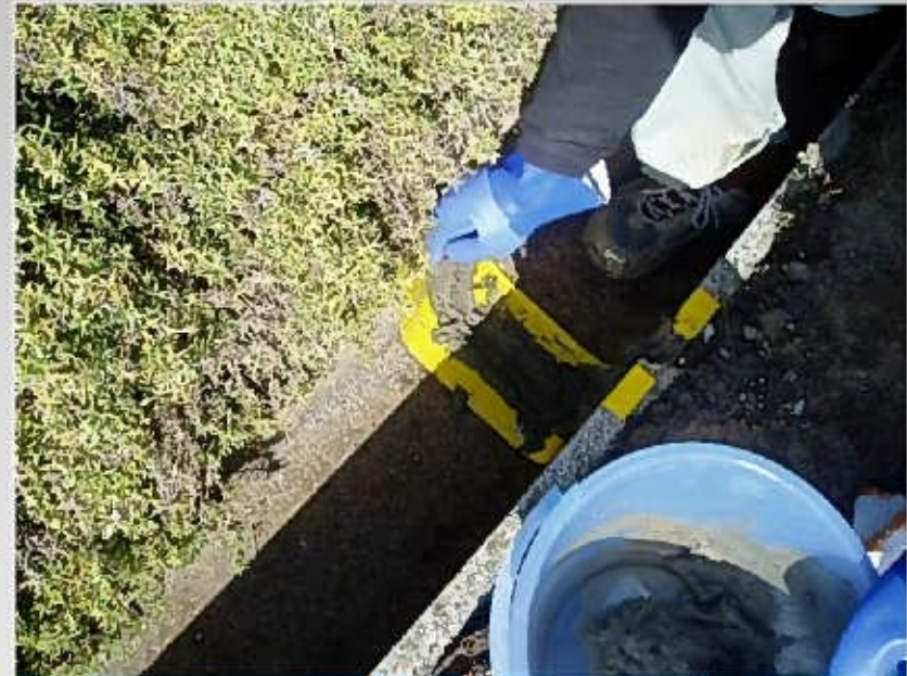
②ゴム手袋等による補修状況
