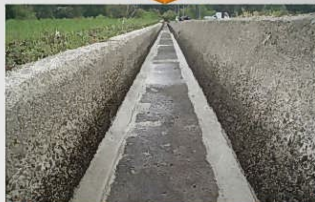
④ ハンチ設置完了
