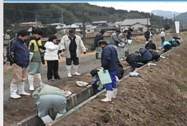
④ 補修状況
