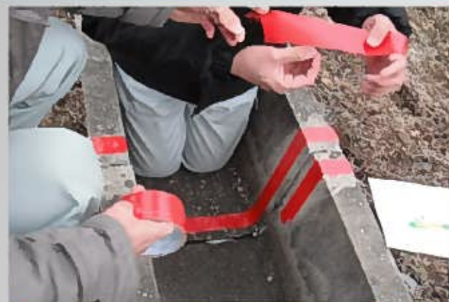
② 養生テープ貼り
