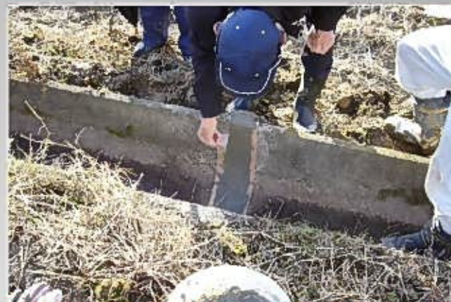
③ 補修状況
