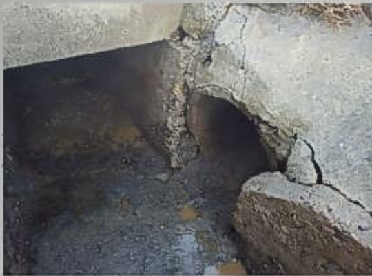
① 取水部の補修
