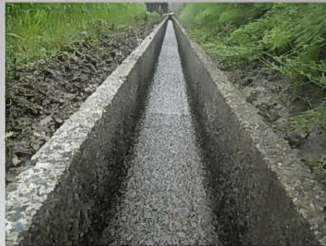
② コンクリート三面張水路
