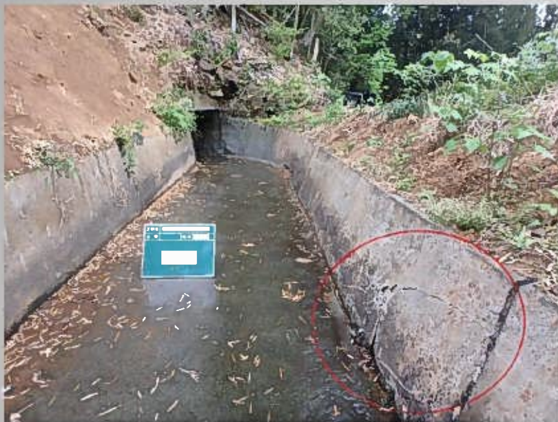
水路側壁部のはく離・欠損
