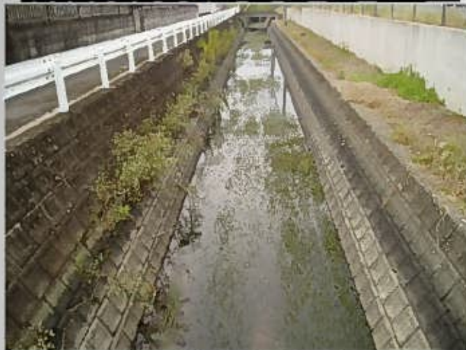
③ ブロック積水路
