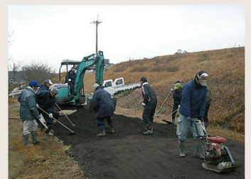
農道路面補修
