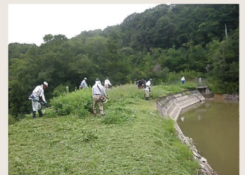
ため池堤防の草刈り
