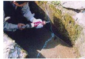
水路のひび割れ補修
