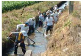
水路の泥上げ
