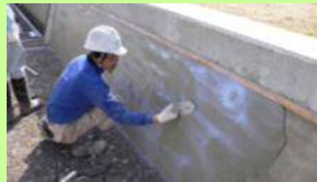
老朽化した水路壁のコーティング
