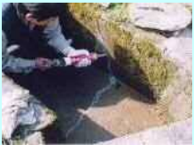
水路のひび割れ補修
