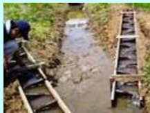
水田魚道の設置
