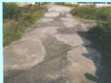
農道の窪みの補修
