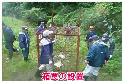
鳥獣防止柵の点検・補修
