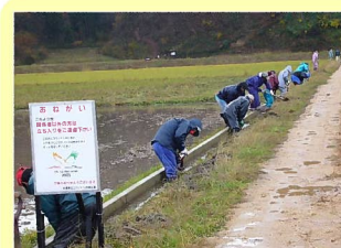
水路の泥上げ
