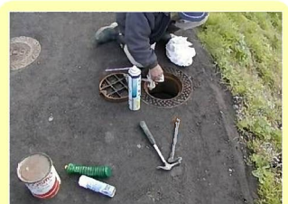
制水弁への腐食防止剤の塗布
